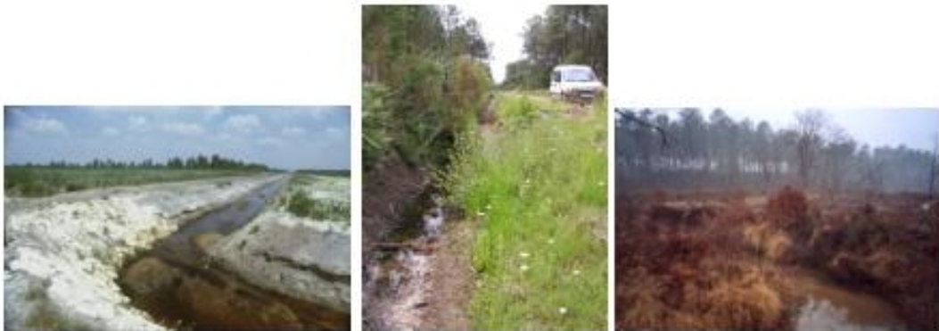
FIGURE 2.1: De gauche à droite : collecteur agricole – fossé en bordure de piste – craste. Photos CEMAGREF
